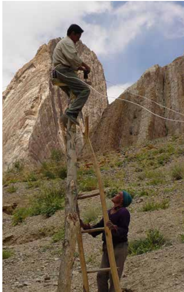
Una línea de transmisión de energía micro-hidroeléctrica siendo instalada por el grupo Ladakh Ecological Development Group (LEDeG) con un poblador de Honupatta en Ladakh, India. Fotografía de Dipti Vaghela.
